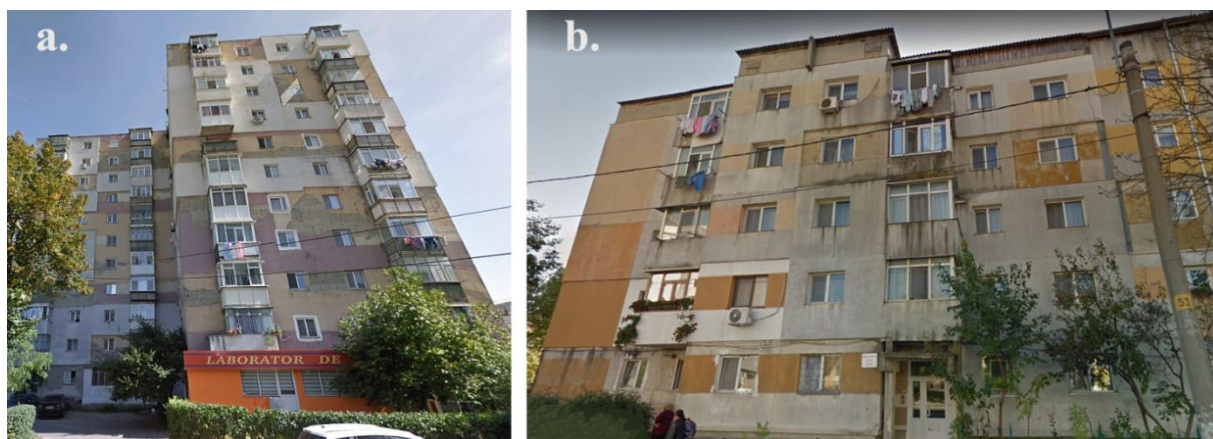
Figura 2 - Locuințe colective cu reabilitare termică etapizată și fațade multicolore.
